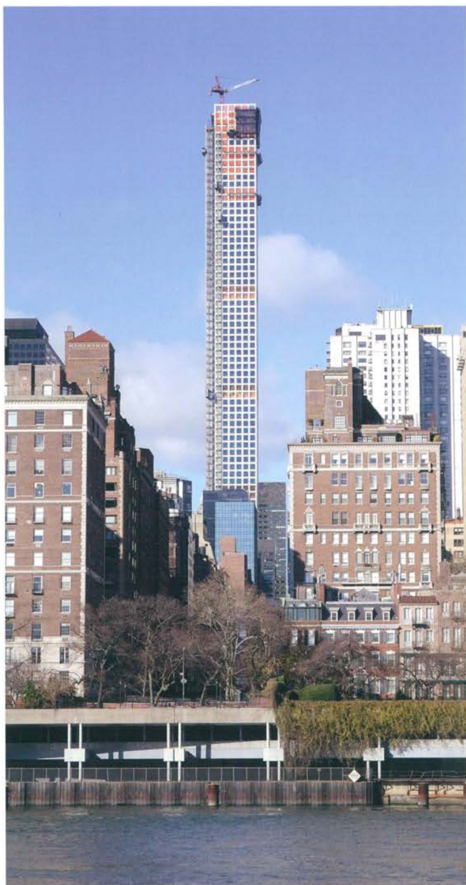
Park Avenue con 57 St (en construcción)
