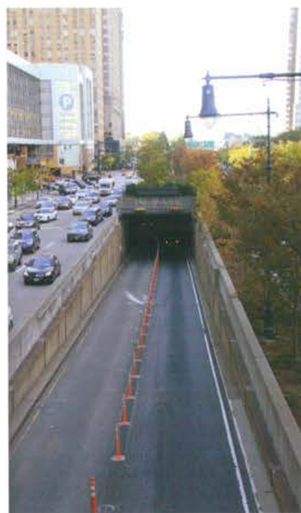
Battery Tunnel, acceso lateral
