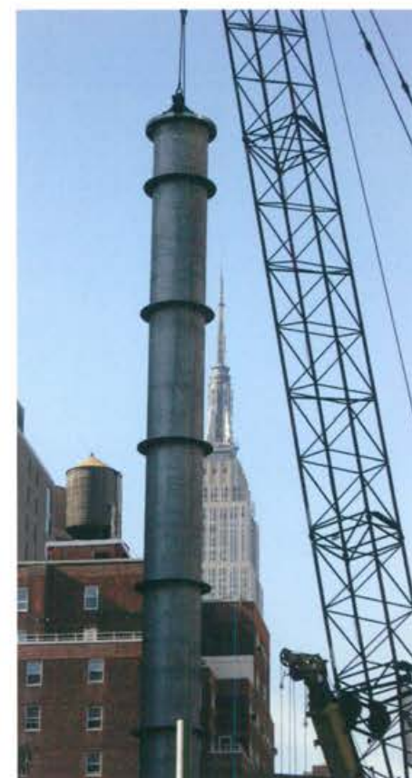
Bombeo de agua, Manhattan, Nueva York, Estados Unidos. 2010
