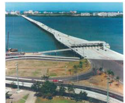
Puente Teodoro Moscoso, Puerto Rico
