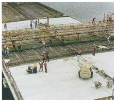
Puente Teodoro Moscoso, Puerto Rico
