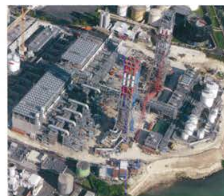
Vista general Pointe Jarry noviembre 2013
