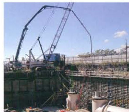
Bombeo de agua, Manhattan, Nueva York, Estados Unidos. 2010
