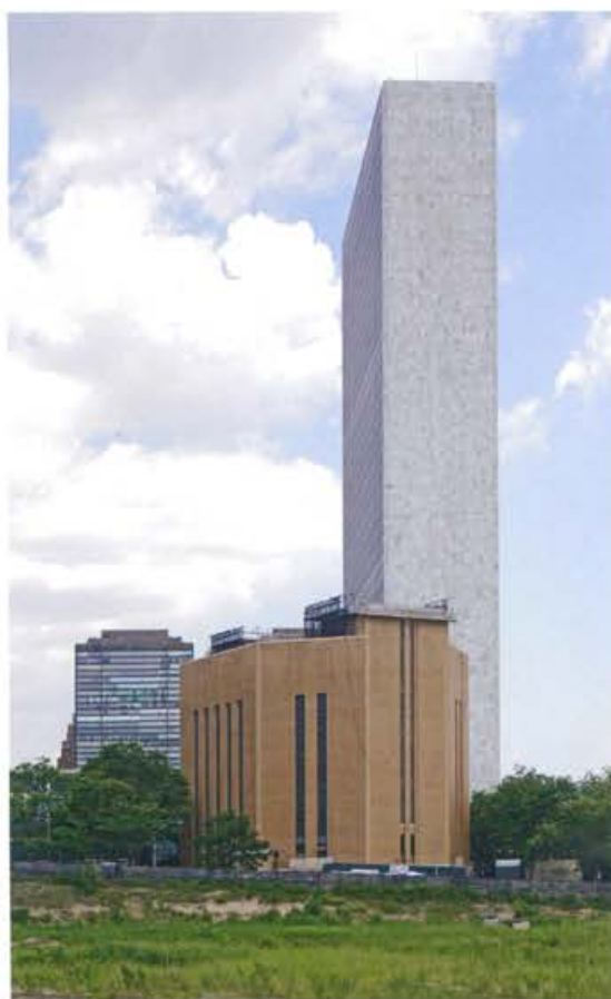
Midtown Tunnel, torre de ventilación
