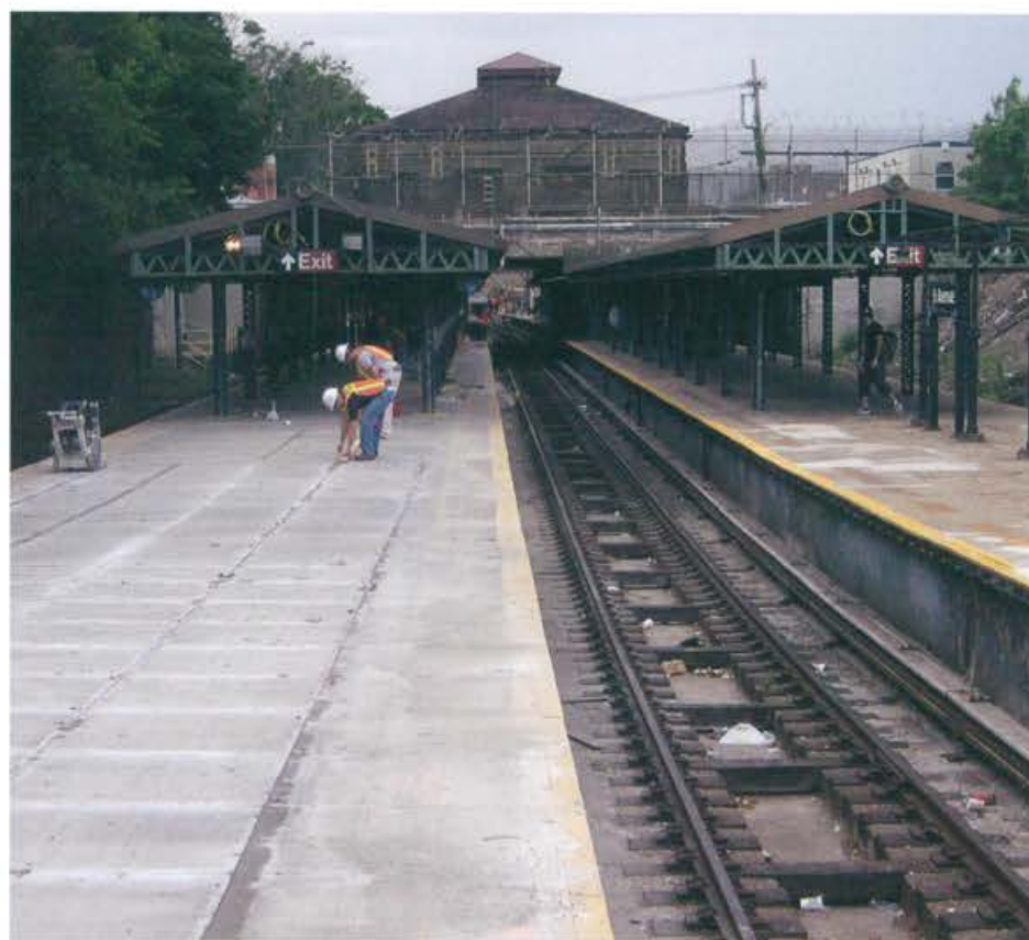
Metro de Brooklin. Rehabilitación 5 estaciones, Nueva York, EEUU. 2010
