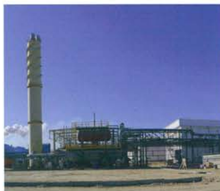
Vapor OCP Marruecos Intecsa
