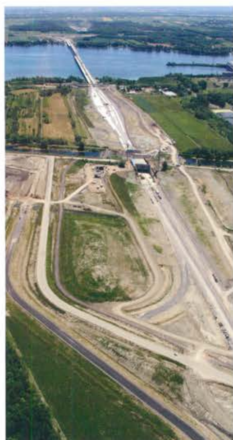
Túnel Soulanges, sector 1. 2012
