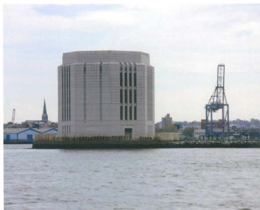
Battery Tunnel, torre de ventilación en Governor's Island
