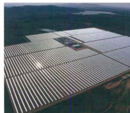
Vista aérea general Termosolar Casablanca
