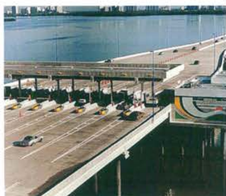
Puente Teodoro Moscoso, Puerto Rico
