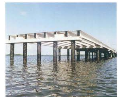
Puente Teodoro Moscoso, Puerto Rico
