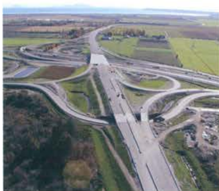
SFPR Interseccion con la Highway 99
