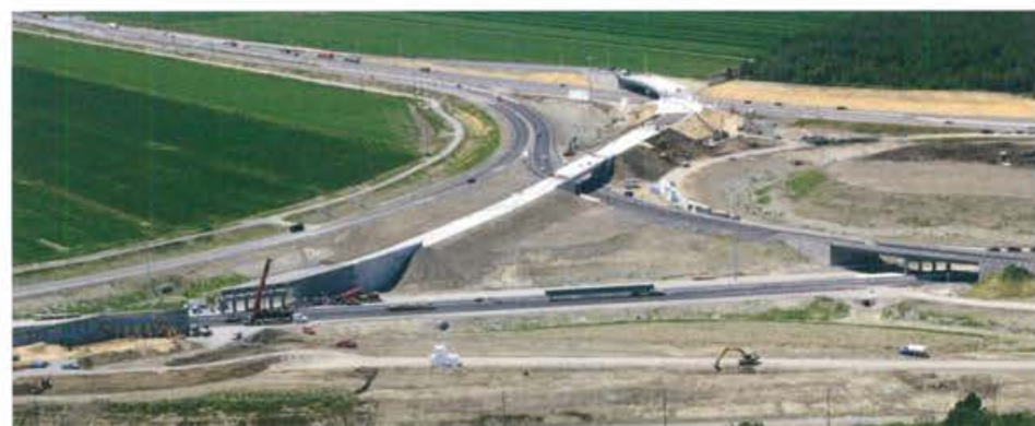
Vue échangeur, sector 1. 2012
