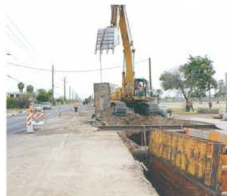
Broadway Sewer Pulice, USA. 2015
