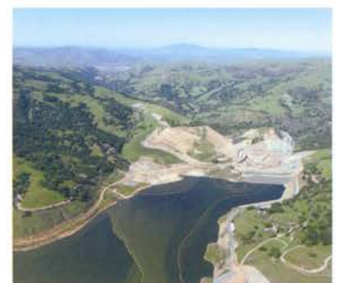
Calaveras Dam, USA. 2016
