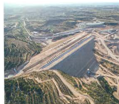
Albagès Dam, Lleida. 2016
