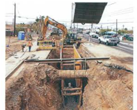
Broadway Sewer Pulice, USA. 2015
