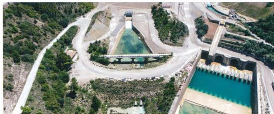
Yesa Dam, Navarra. 2016
