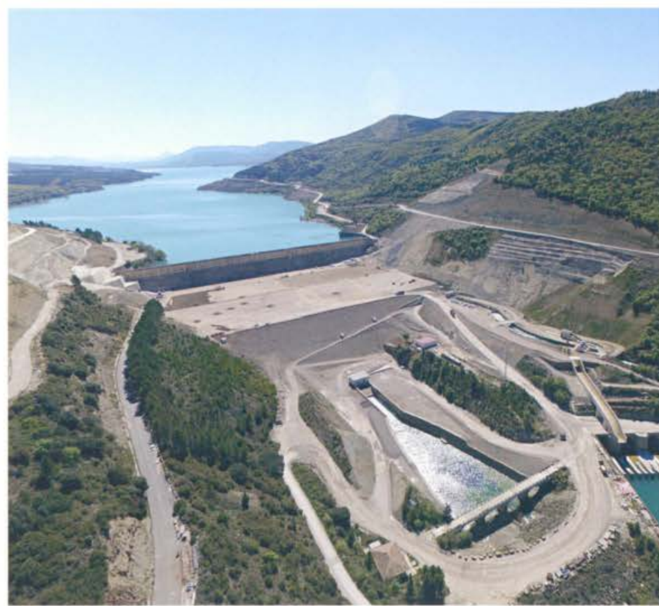
Yesa Dam, Navarra. 2016
