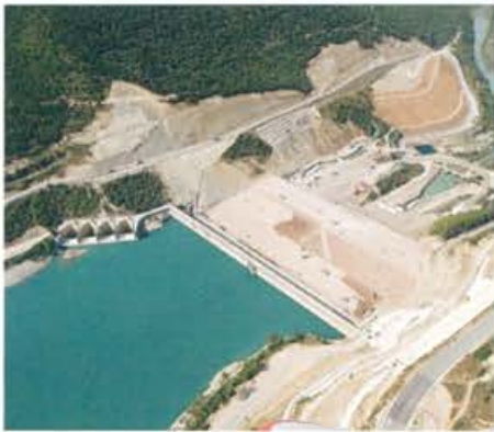
Yesa Dam, Navarra. 2016
