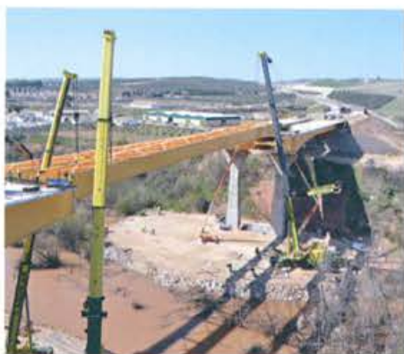
Viaduct Linares-Ibros, Jaén. 2015
