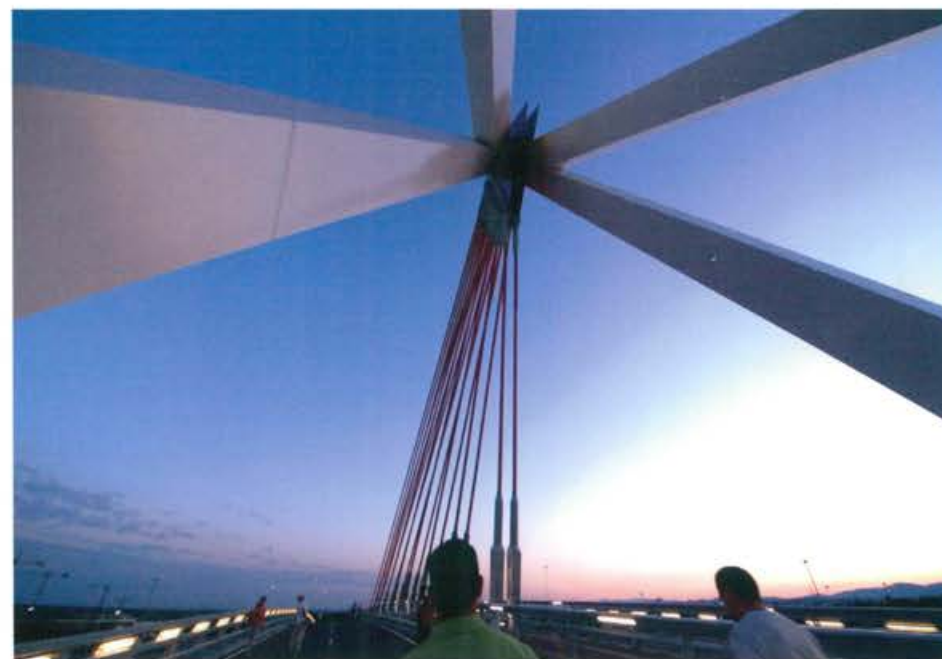
Las Rozas cable-stayed bridge over the A6 Arenas, 2006
