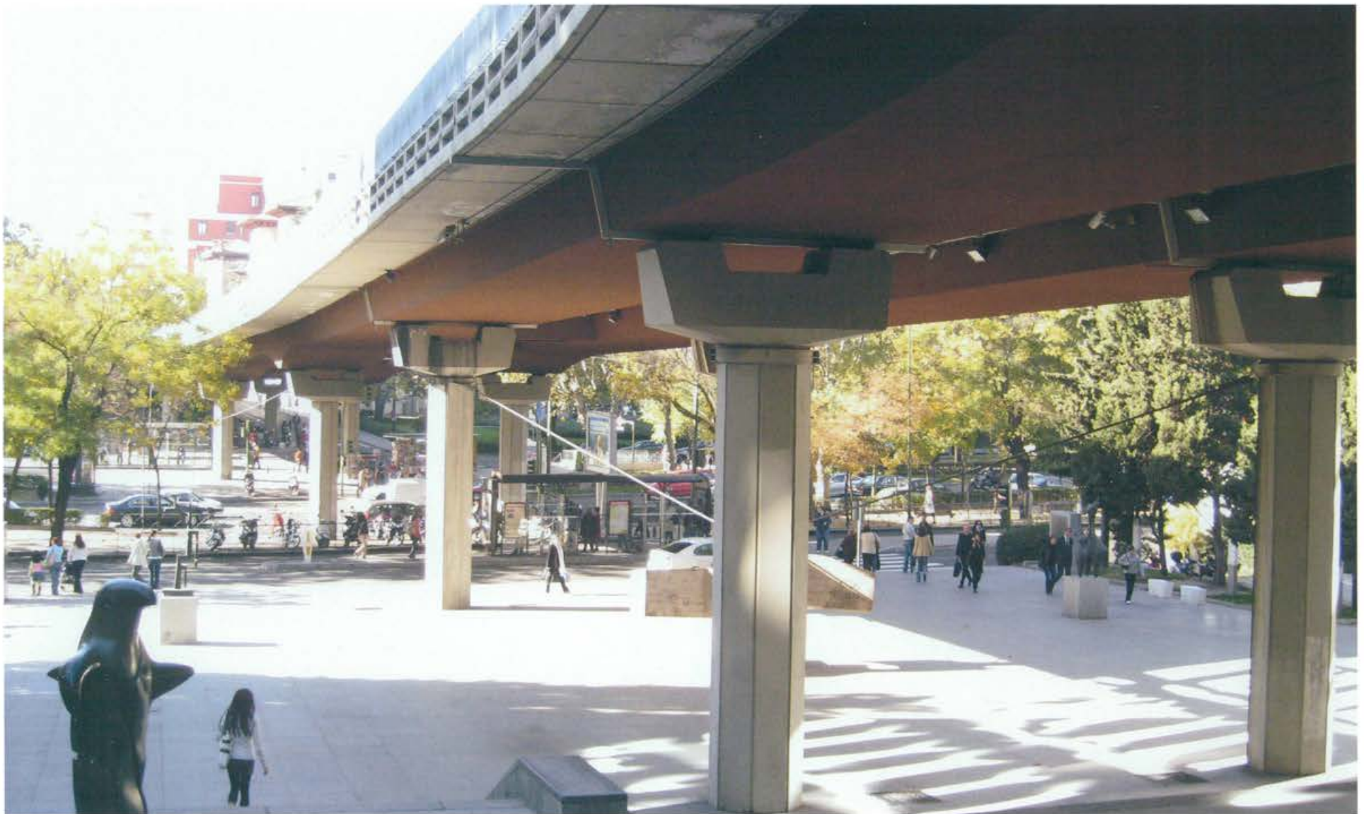
Juan Bravo Bridge over the Paseo de la Castellana in Madrid (Fernández Ordóñez, Martínez Calzón, Corral, 1971)
