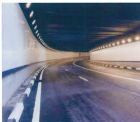
Underpasses on the Calle de Ríos Rosas. 1998
