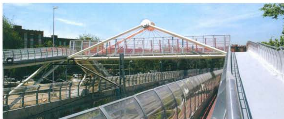
Footbridges at Entrevías
