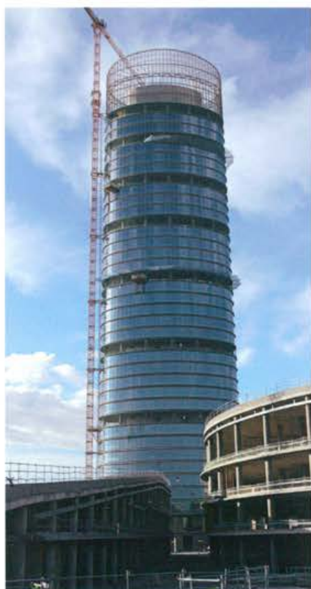
Torre Pelli, Sevilla, 2014
