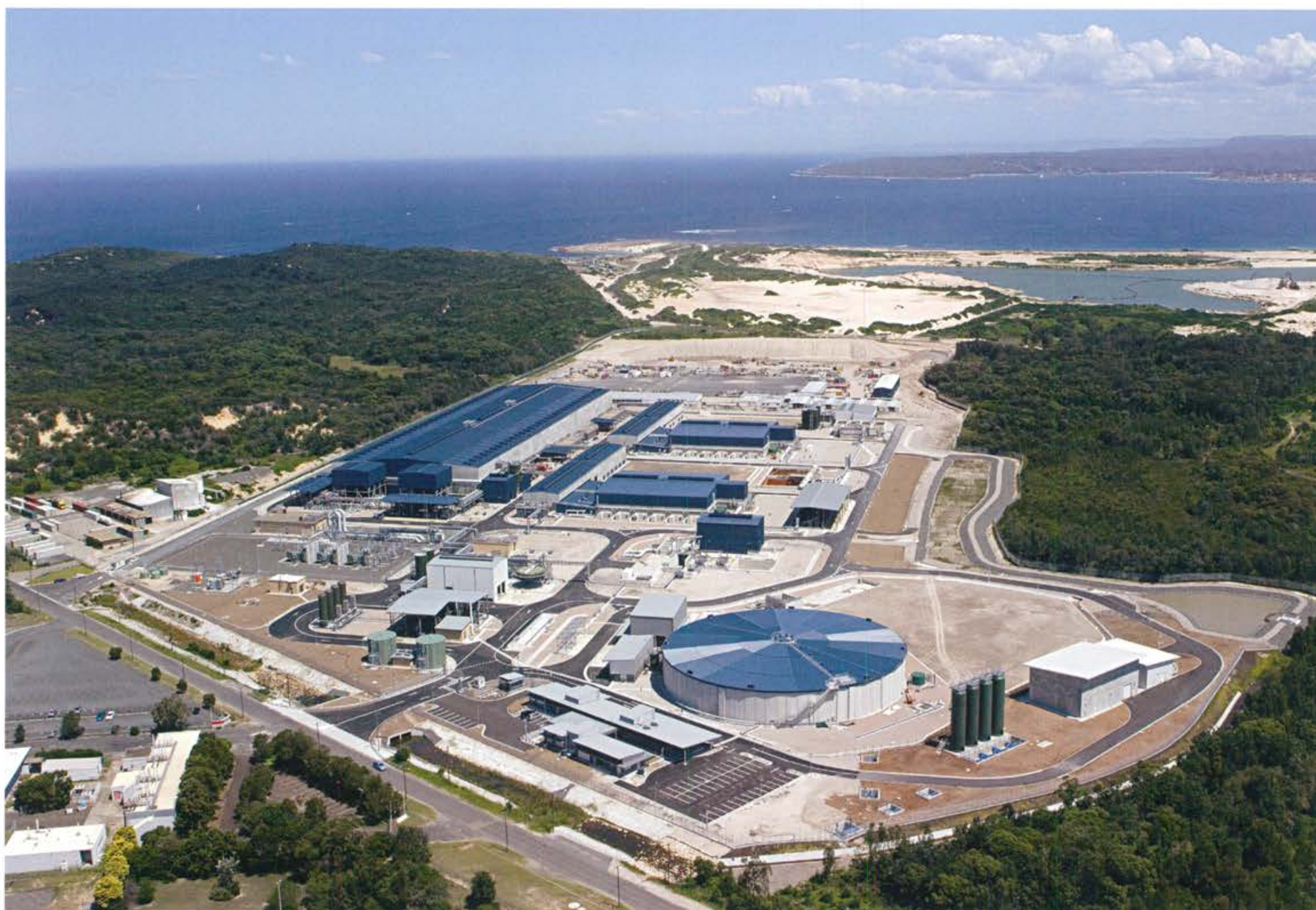
Sydney Desalination Plant, Botany Bay. Construida por ACS, 2010
