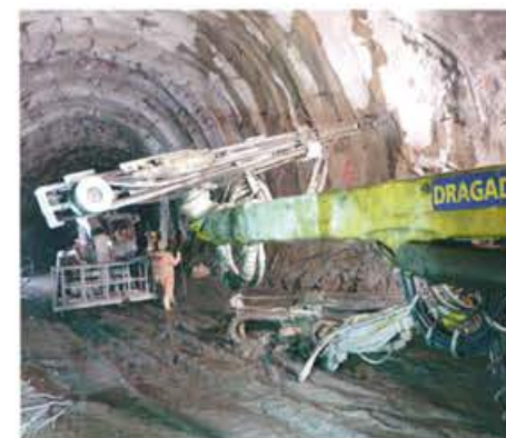
Doble Calzada Bogotá-Villavizencio, Colombia. 2016
