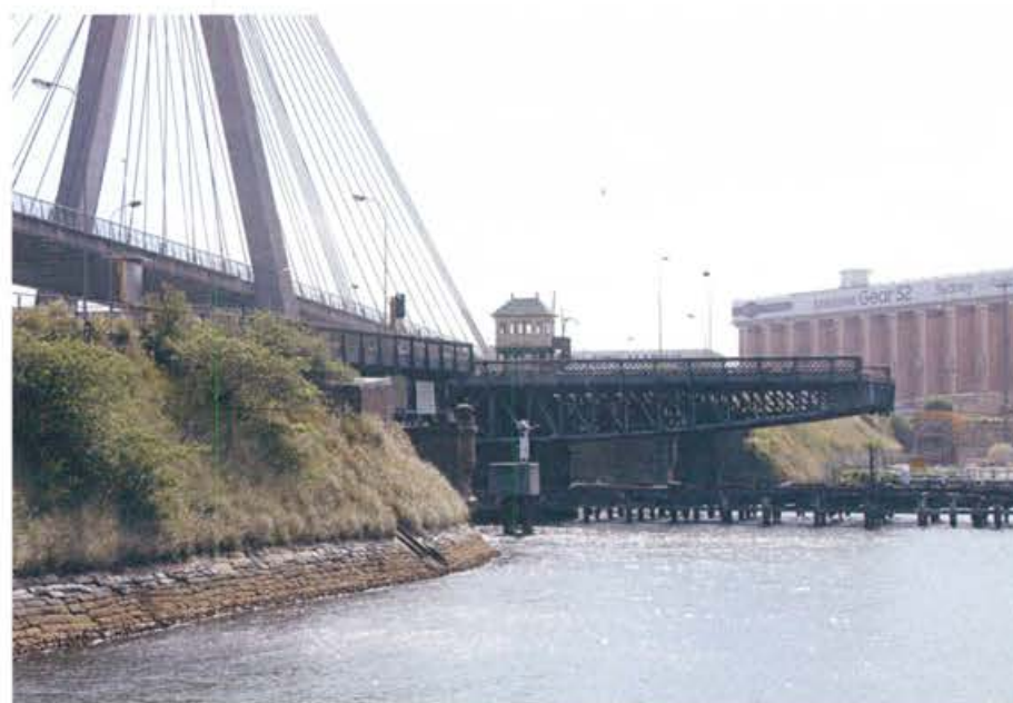
Tramo abierto del antiguo Glebe Swing Bridge
