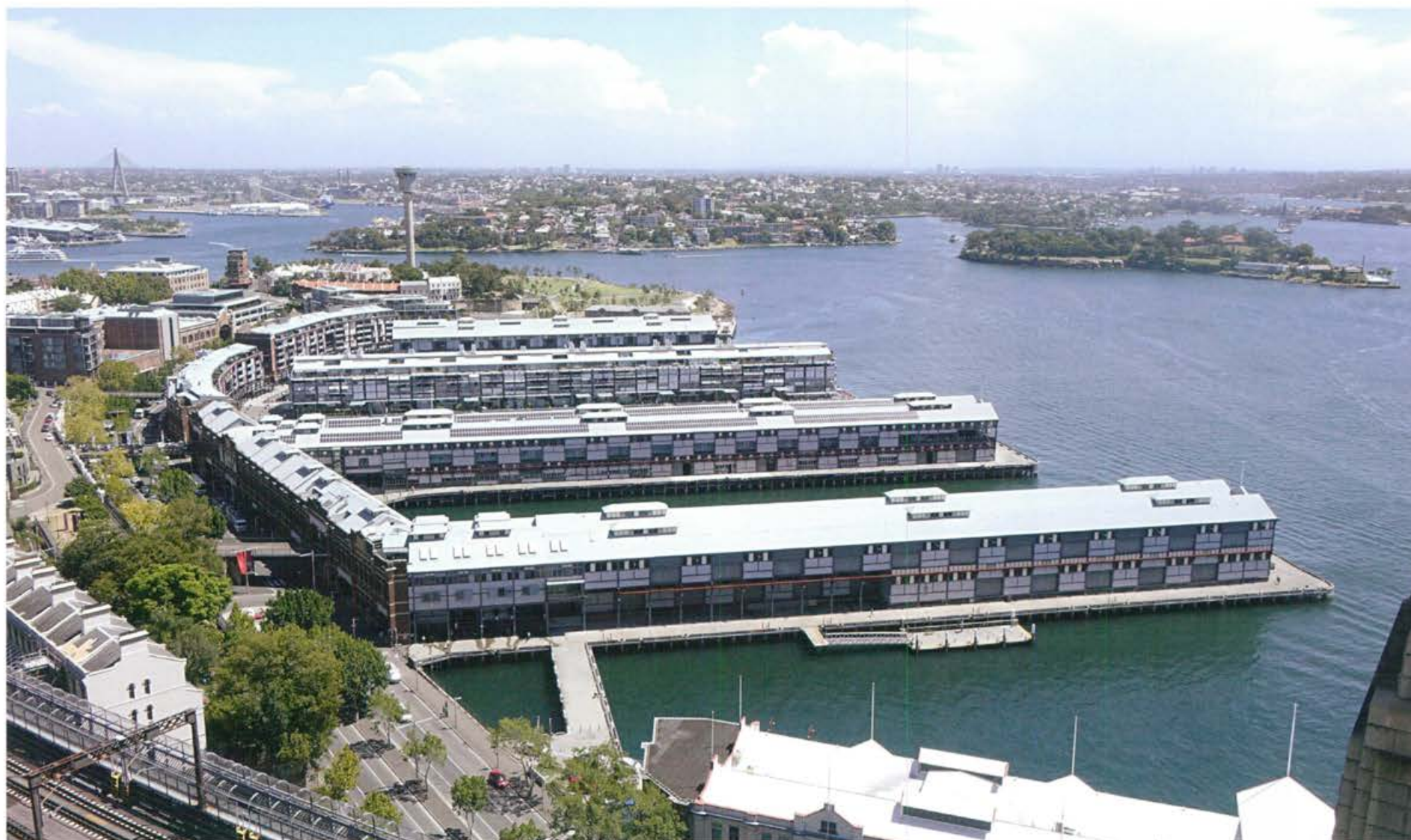
Rehabilitación de los fingers de Walsh Bay
