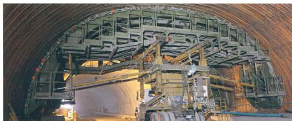
Doble Calzada Bogotá-Villavieja, Colombia. 2016
