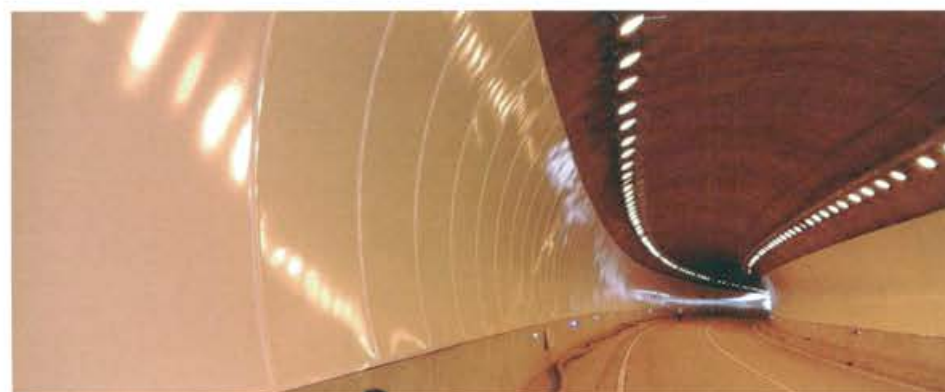
Doble Calzada Bogotá-Villavizencio, Colombia. 2016
