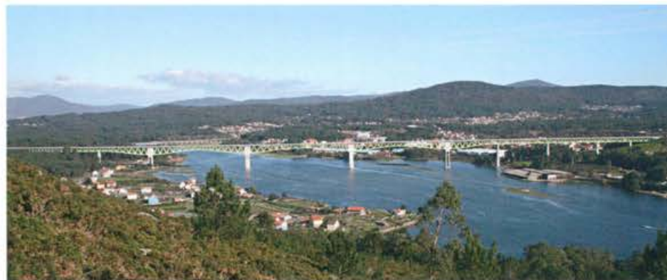
Viaducto sobre el río Ulla, Pontevedra. 2015
