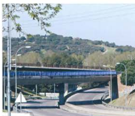
Gestión Infraestructuras viarias. Enlace A6 M30, Madrid. 2015
