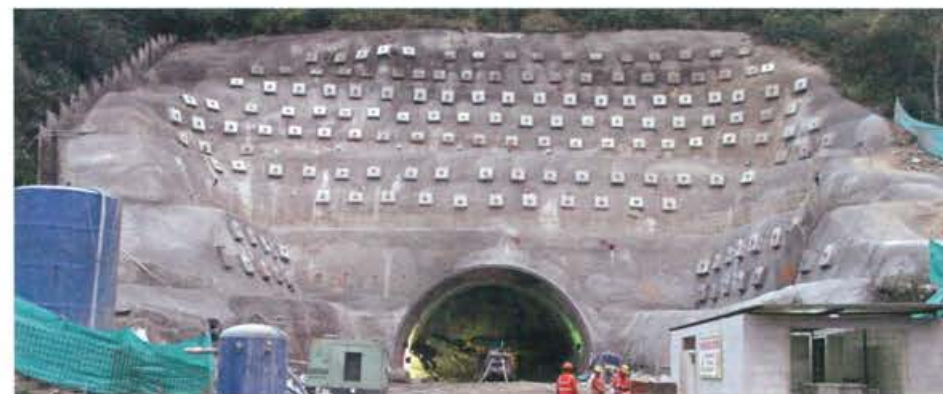
Doble Calzada Bogotá-Villavieja, Colombia. 2015
