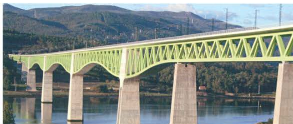
Viaducto sobre el río Ulla, Pontevedra. 2015
