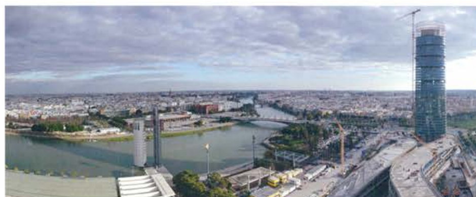
Torre Pelli, Sevilla, 2014
