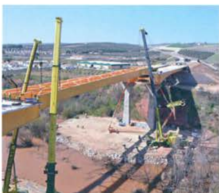
Viaducto Linares-Ibros, Jaén. 2015
