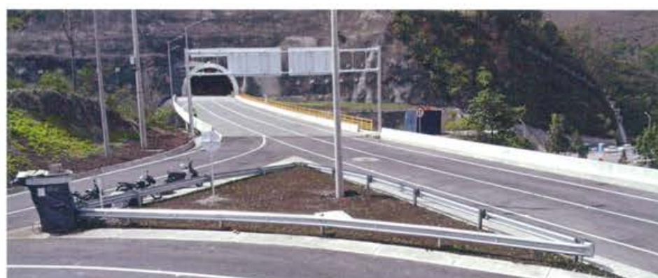
Doble Calzada Bogotá-Villavizencio, Colombia. 2016
