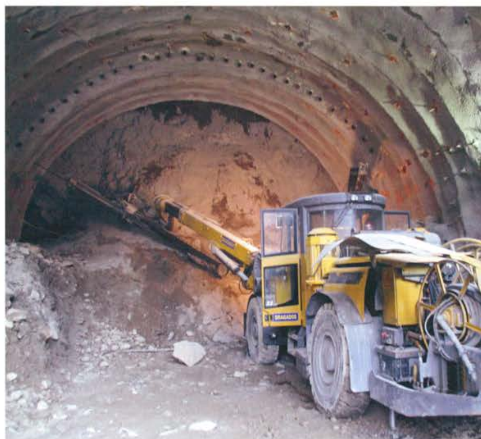
Doble Calzada Bogotá-Villavizencio, Colombia. 2015
