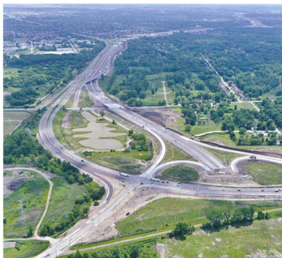
Autopista Windsor Essex Parkway, Ontario, Canadá. 2015
