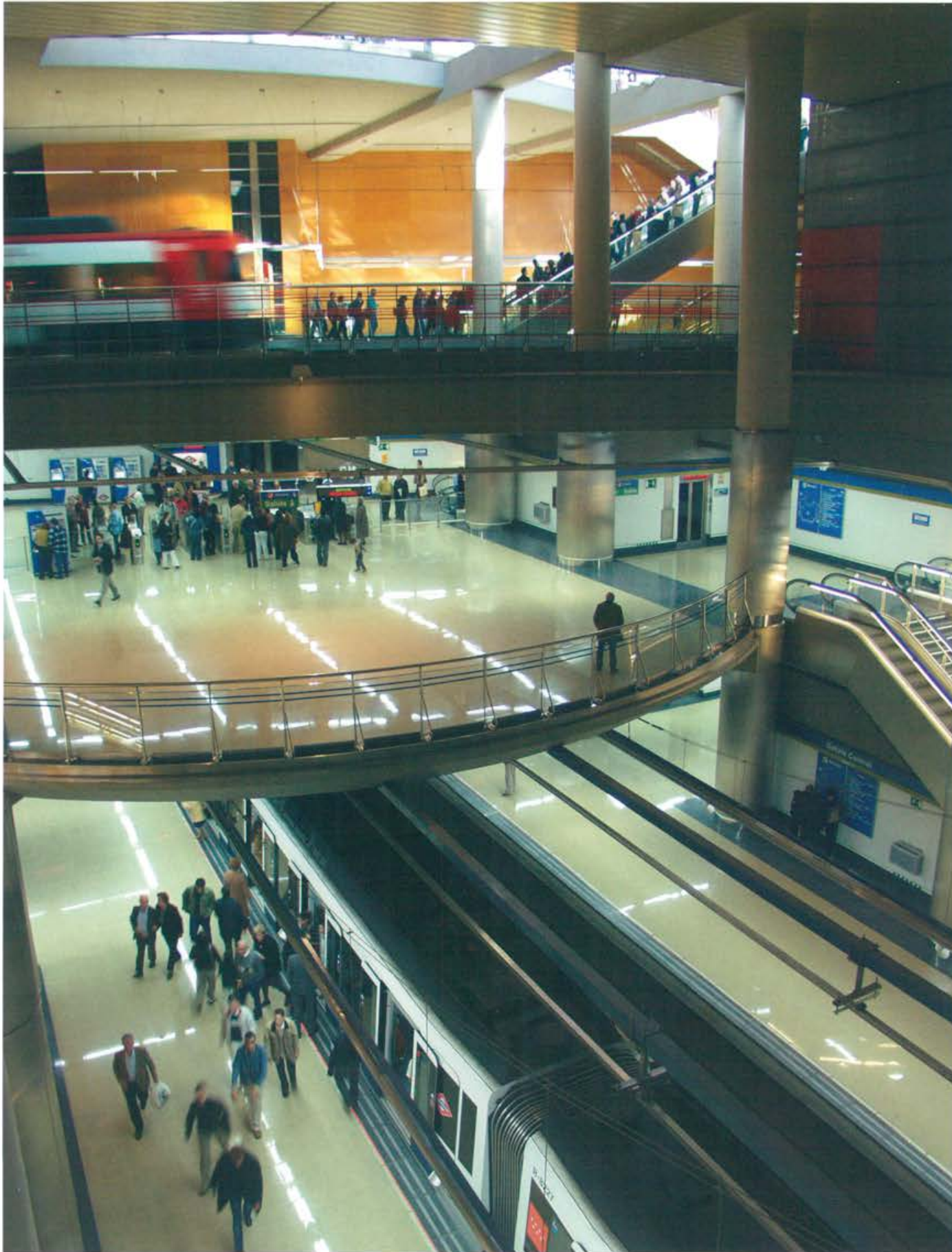
Estación de Metrosur Puerta del Sur
