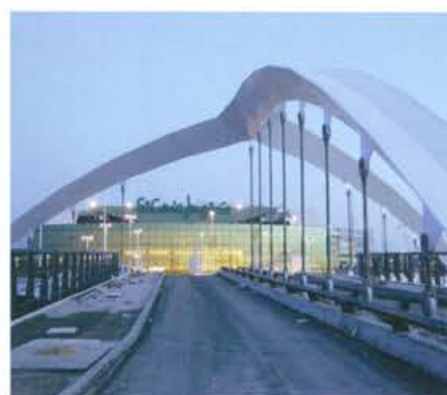
Pasarela de El Corte Inglés de Sanchinarro. Paso 2
