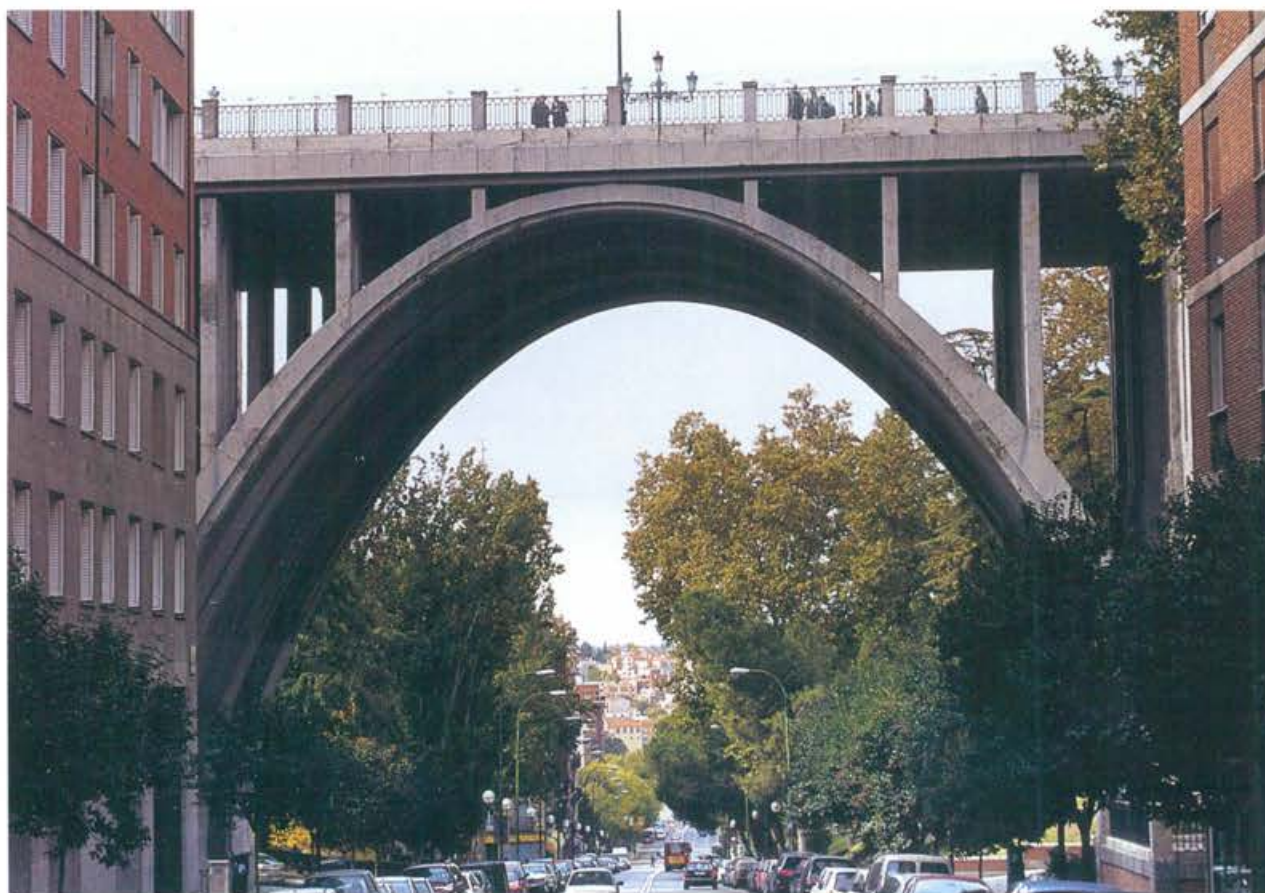
Nuevo viaducto de Madrid
