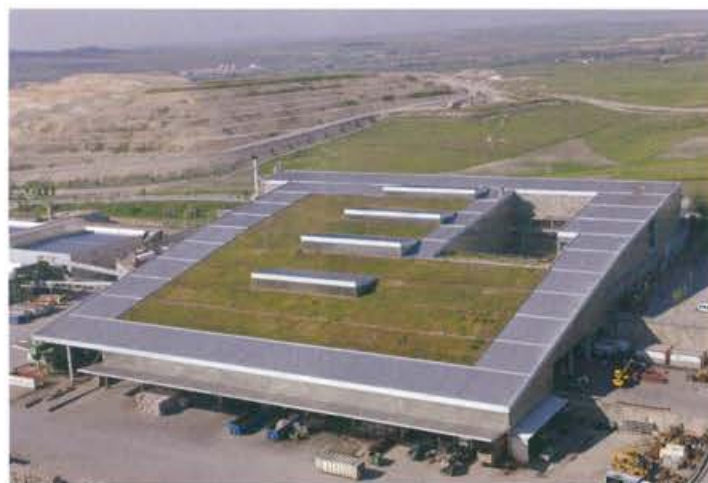
Planta de reciclaje de Valdemingómez [Foto: Iñaki Ábalos]
