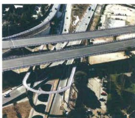
Pasarela enlace del Pardo M-30 con M-40
