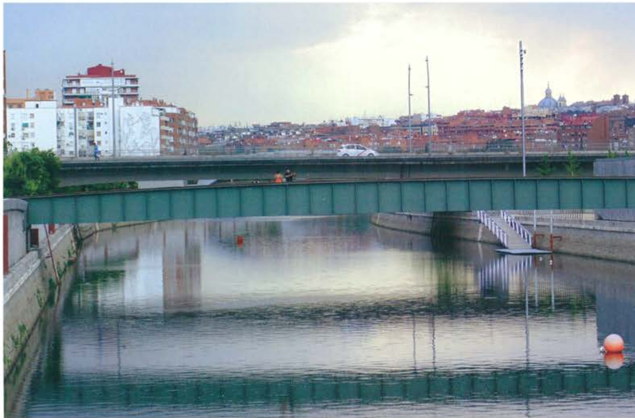
Pasarela de la Princesa
