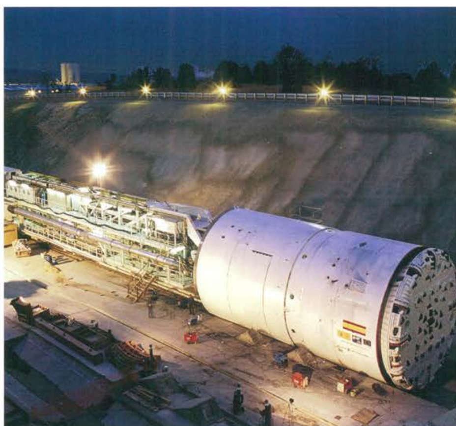
Túnel de Guadarrama, boca sur. 2005
