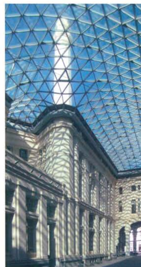
Palacio de Comunicaciones
