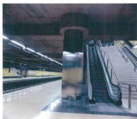
Estación de Metro, Línea 11. 1997
