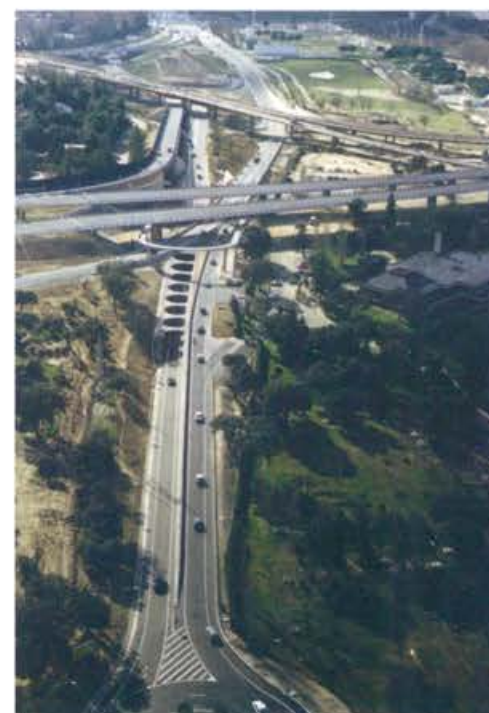
Pasos del cruce de la M-40 sobre la A1 Pantaleón, 1999
