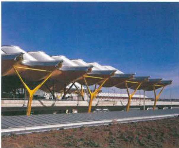
Aeropuerto de Barajas T4 en Madrid
