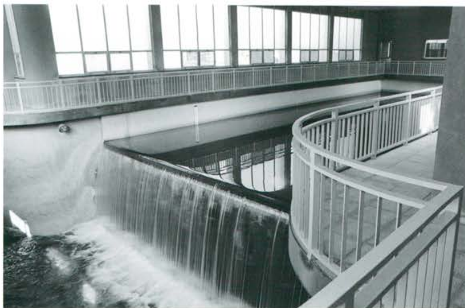
Entrada en depósito inferior de Plaza de Castilla
