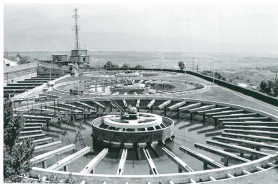
Potabilizadora de Torrelaguna [Foto: Antonio Sarabia]
