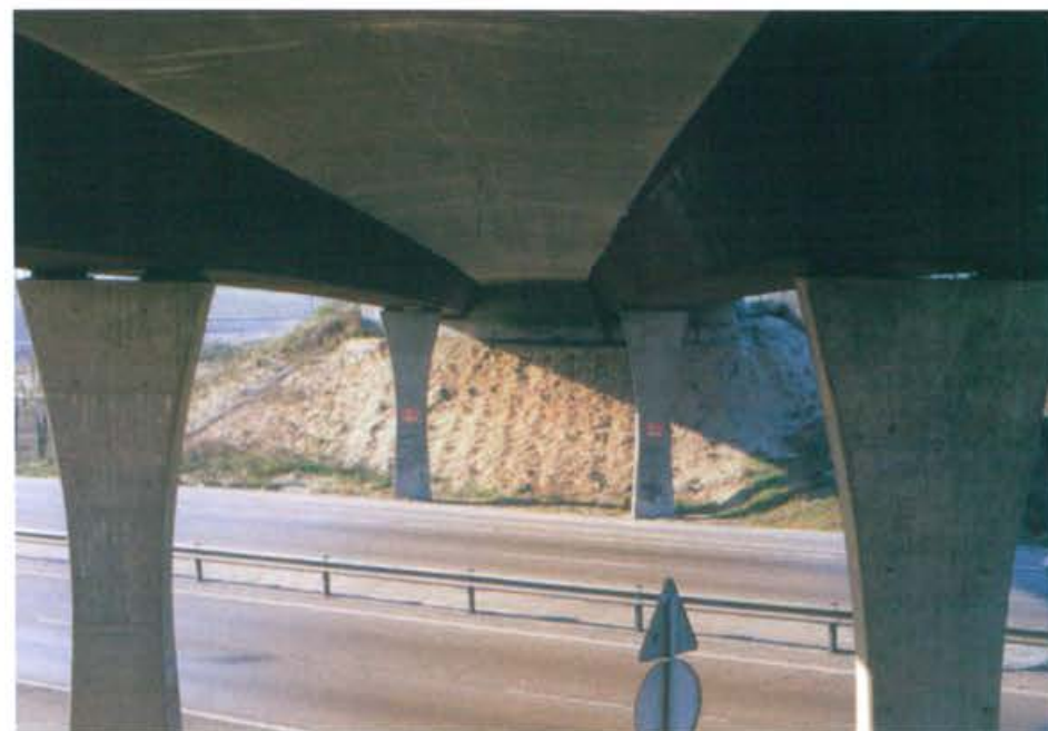
Puente de la M-603 sobre la M-607, autovía de Colmenar Viejo Rui-Wamba, 1986
