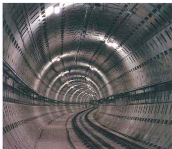
Tuneladora para el Metro de Madrid
