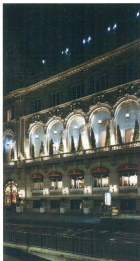
Casino de Madrid [Rehabilitación]
