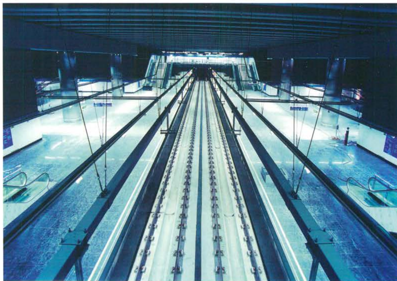
Estación de Metrosur Puerta del Sur
