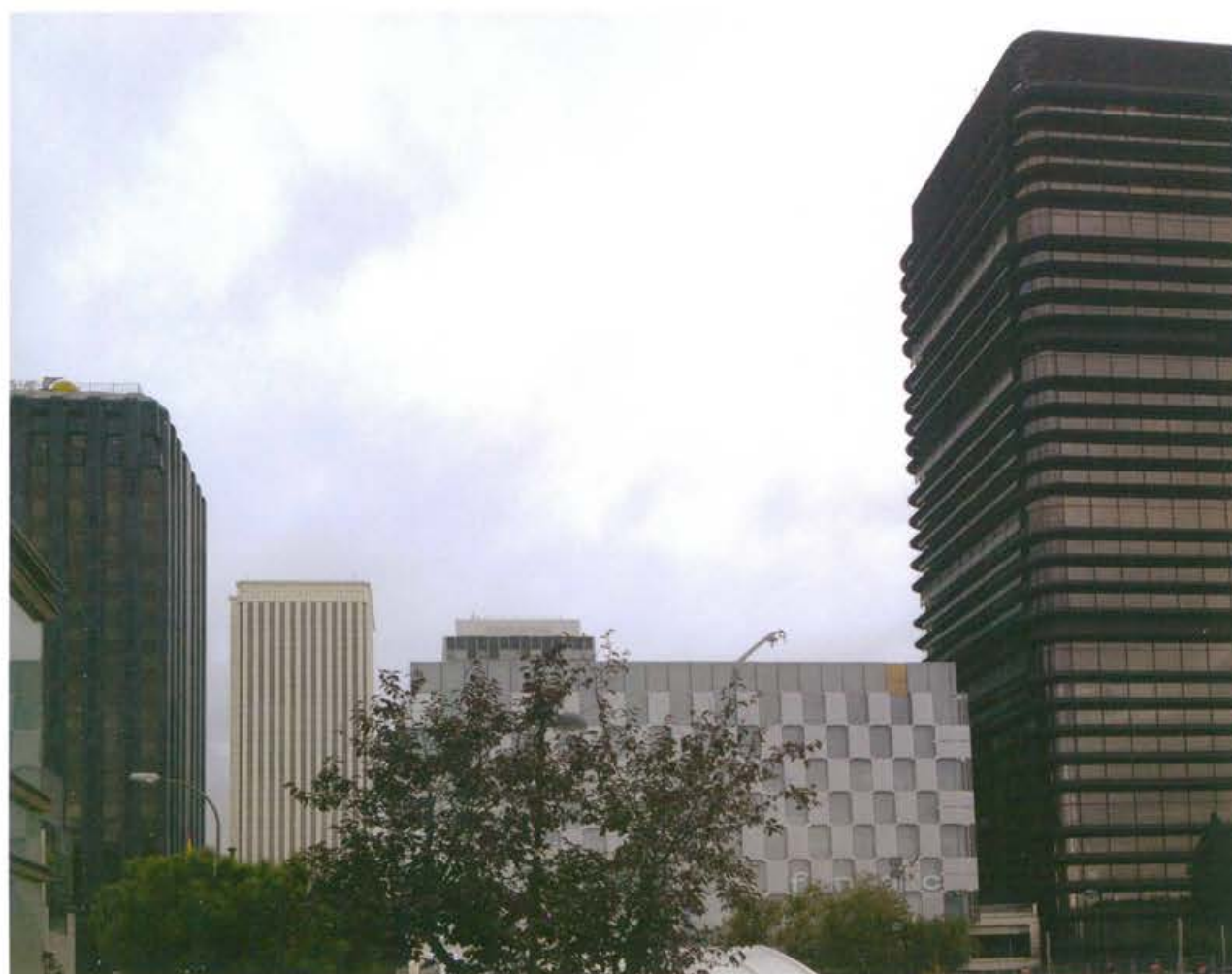
Edificios en el complejo AZCA
