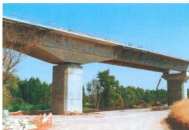
Viaducto de la LAV Madrid-Barcelona sobre el río Jarama Millanés, 2003
