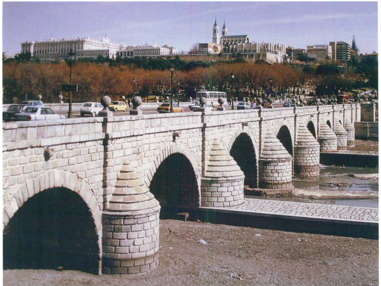
Puente de Segovia Herrera, 1584
