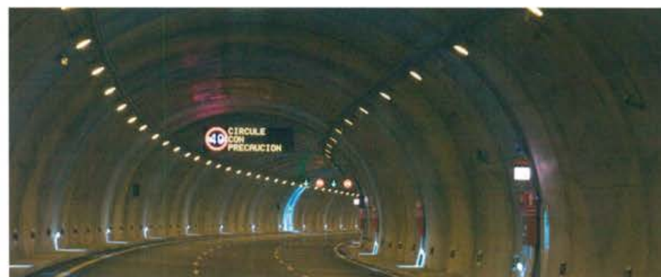
Autopista AP-6. Túnel de Guadarrama. 2007
