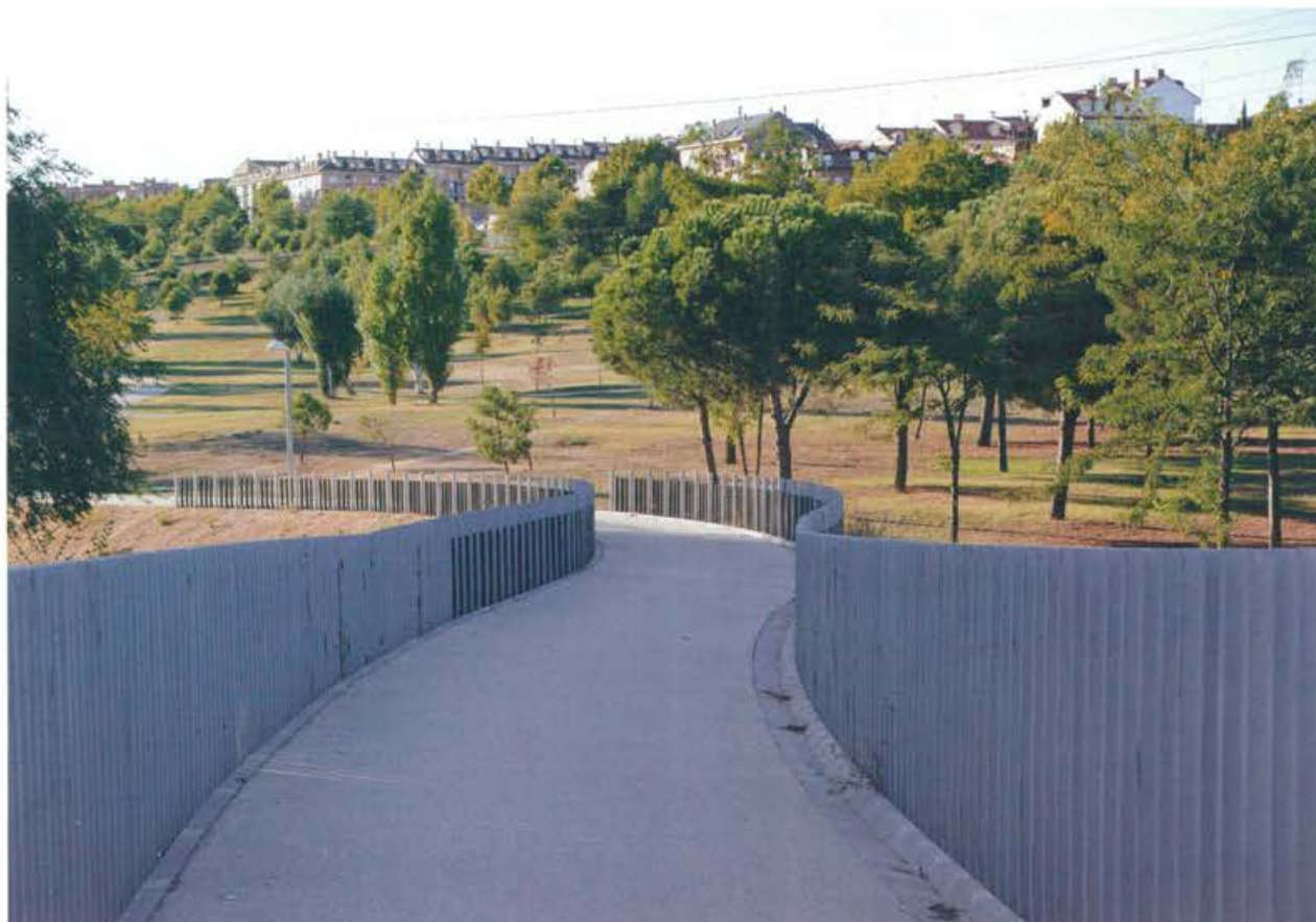
Pasarela en el Parque Butarque en Leganés
