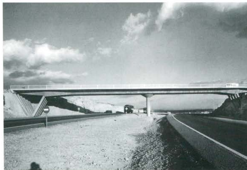
Puente de Hoyo de Manzanares sobre la A6
