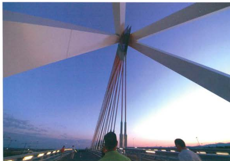
Puente atirantado de Las Rozas sobre la A-6 Arenas, 2006
