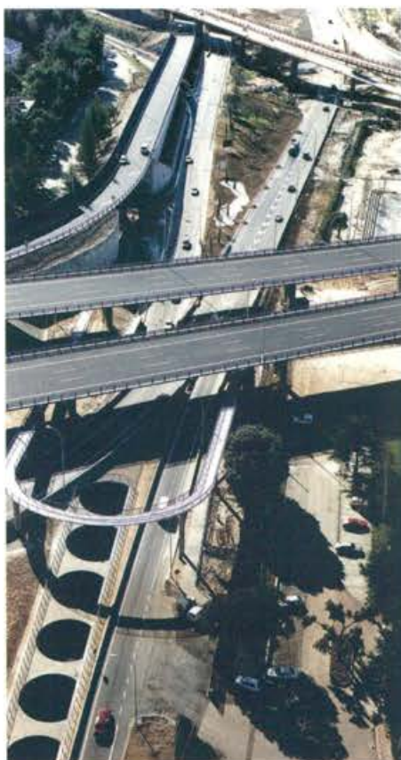
Pasarela enlace del Pardo M-30 con M-40
