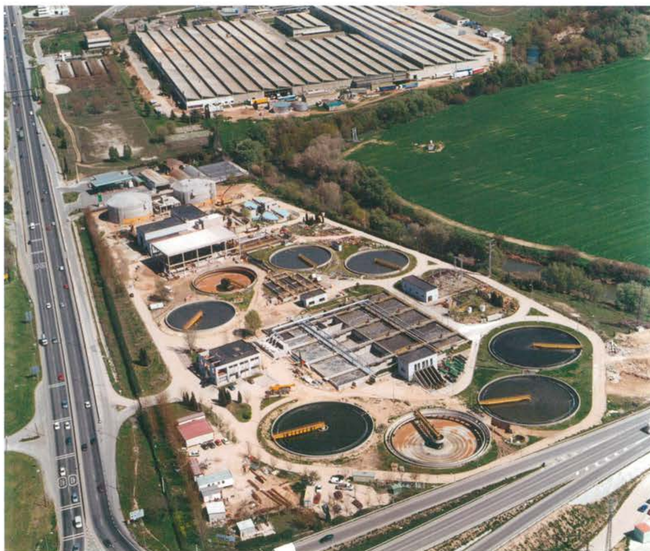
Depuradora Alcalá Oeste-Industrial
