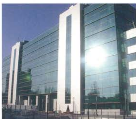
Edificio Oficinas Metrovacesa
