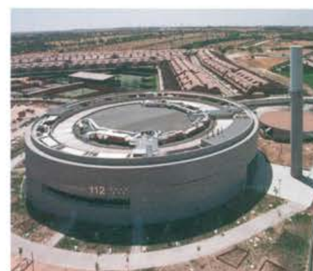
Centro de Emergencias de la CAM
