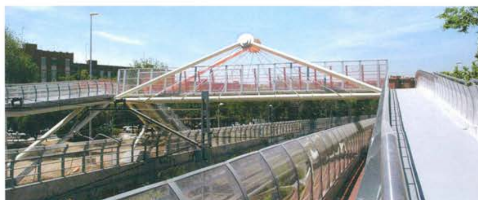
Pasarelas en Entrevías
