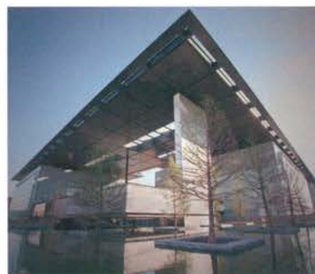
Ciudad de las Telecomunicaciones. Telefónica
