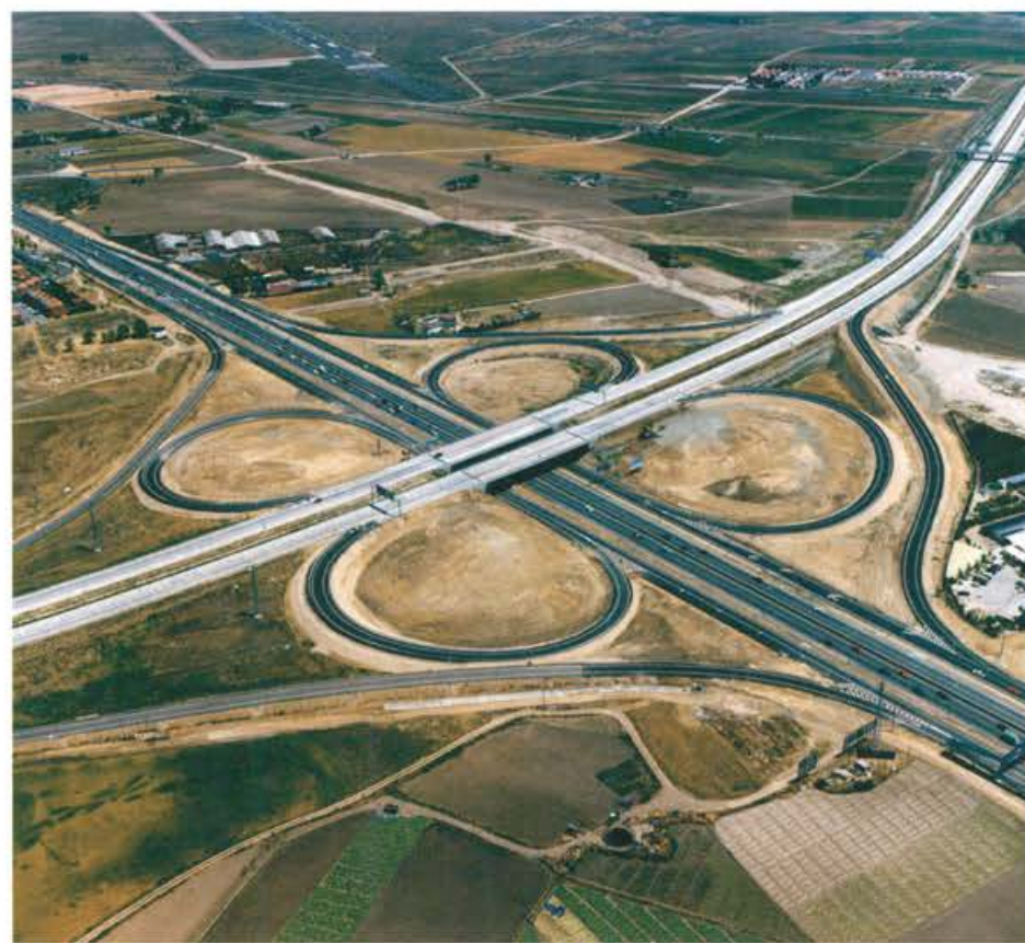
Conexión M-50 con Autovía de Toledo
