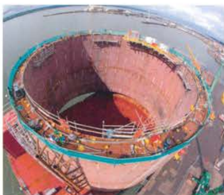
Nuevo Puente Queensferry Crossing, Escocia
