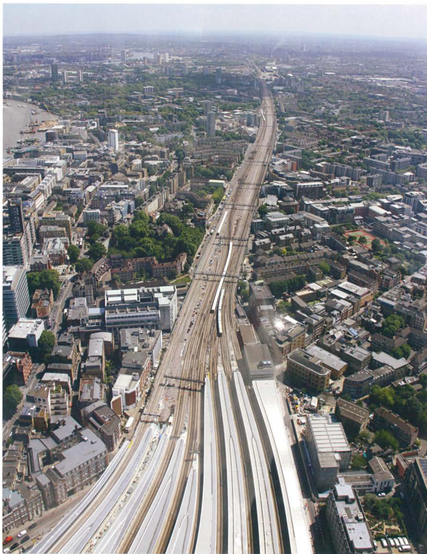
Playa de vías de London Bridge Station desde The Shard
