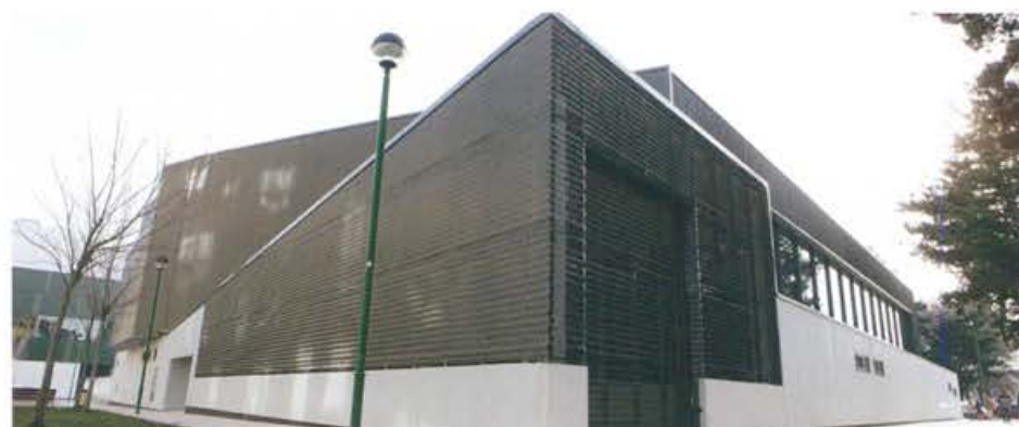
Sala Escolar polideportiva, Burgos
