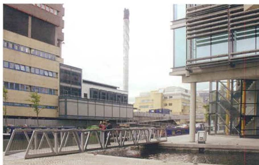
Pie de foto: Bridge-Paddington Basin (Heatherwick studio & Anthony Hunts) - La estructura se abre por medio de una serie de cilindros hidráulicos dispuestos en la plataforma de vigas del puente; conforme se va enrollando, cada uno de sus ocho segmentos se eleva simultáneamente, hasta que los dos extremos se tocan formando un octógono 21
