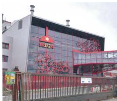
Rehabilitación edificio Mega, Galicia
