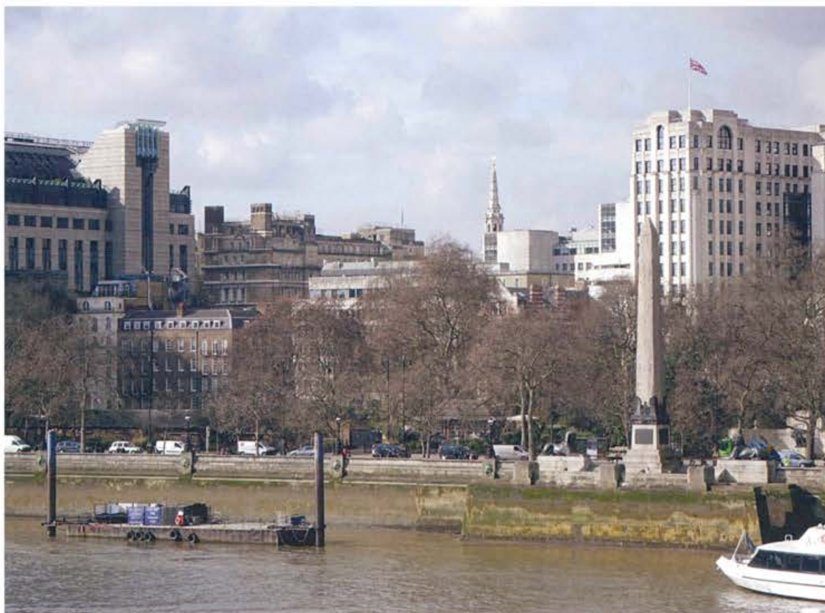
Victoria Embankment-Muro de encauzamiento
