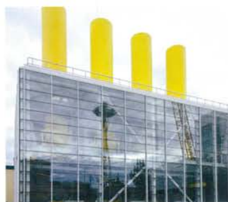
Seattle tunnel, EEUU
