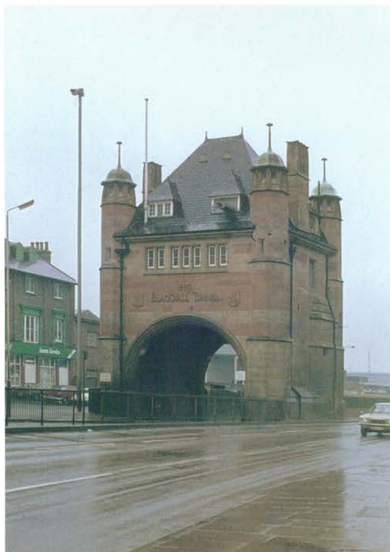
Túnel de Blackwall bajo el Támesis en Londres (1887)
