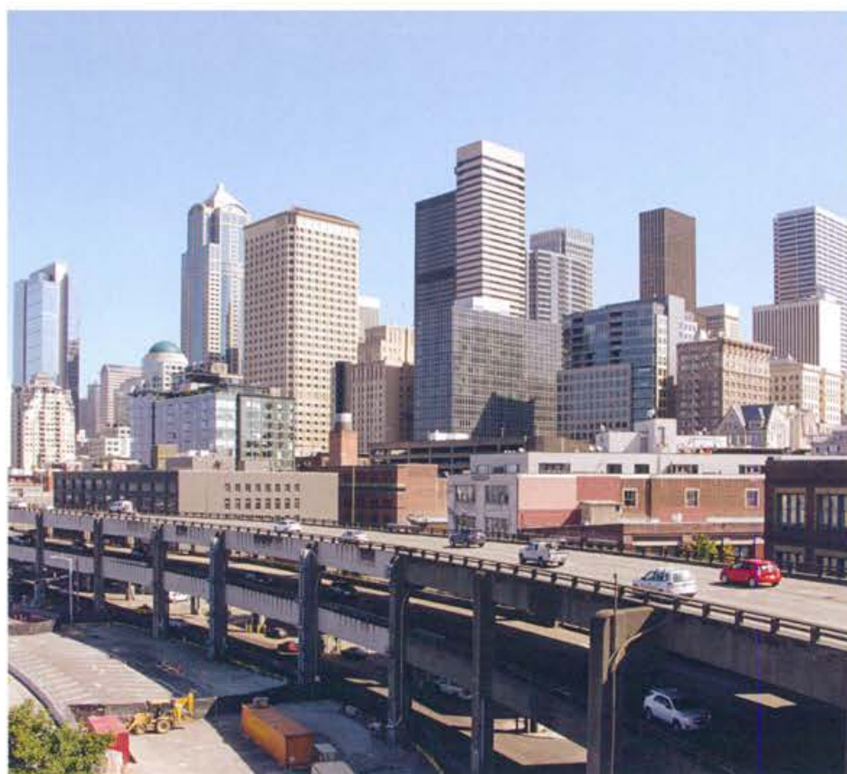
Seattle tunnel, EEUU
