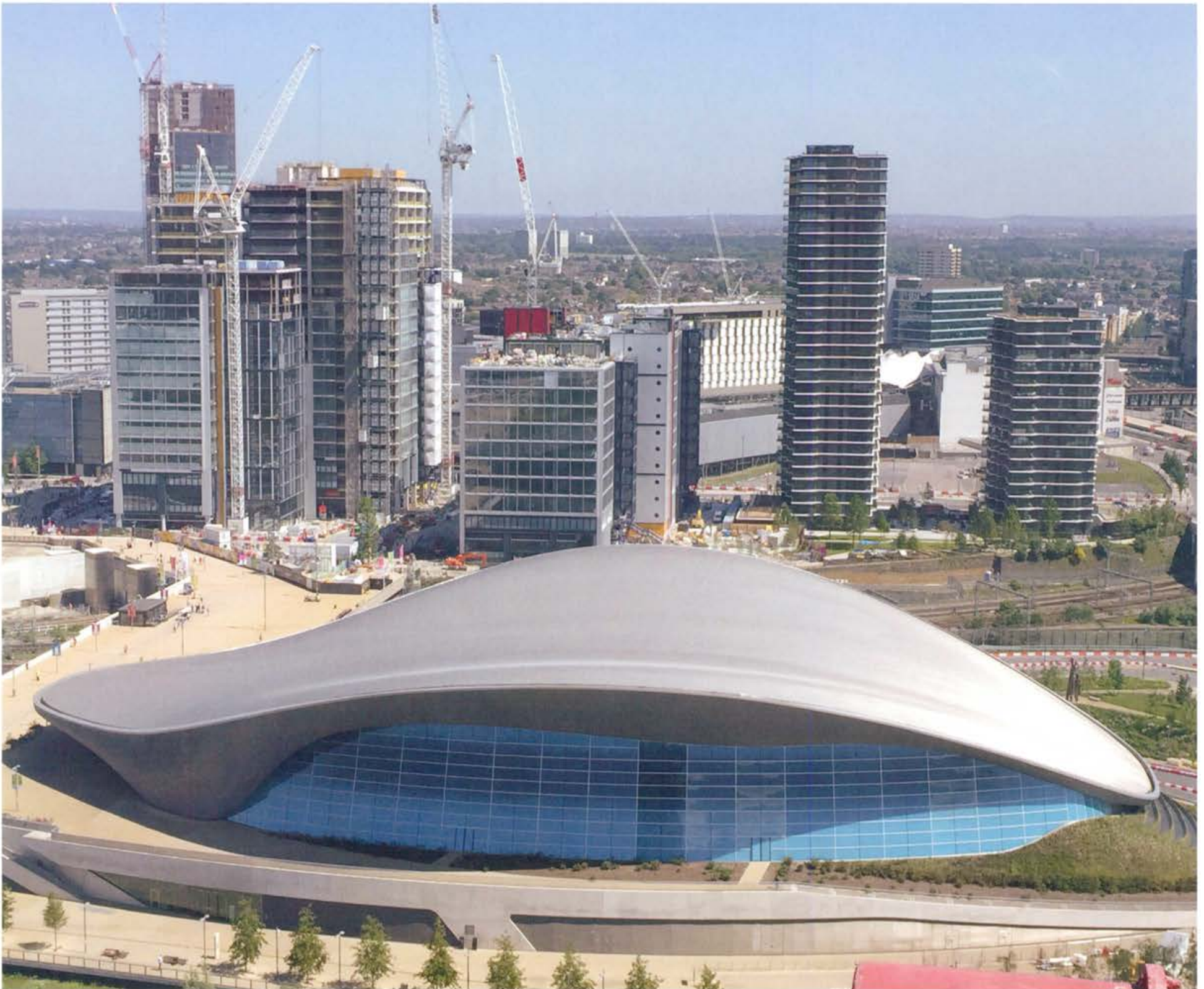
Olympic Pool con la ampliación de Stratford detrás
