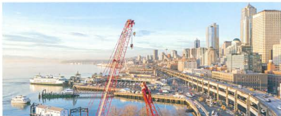
Seattle tunnel, EEUU
