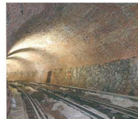
Rehabilitación Metro Línea 1, Madrid. 2016
