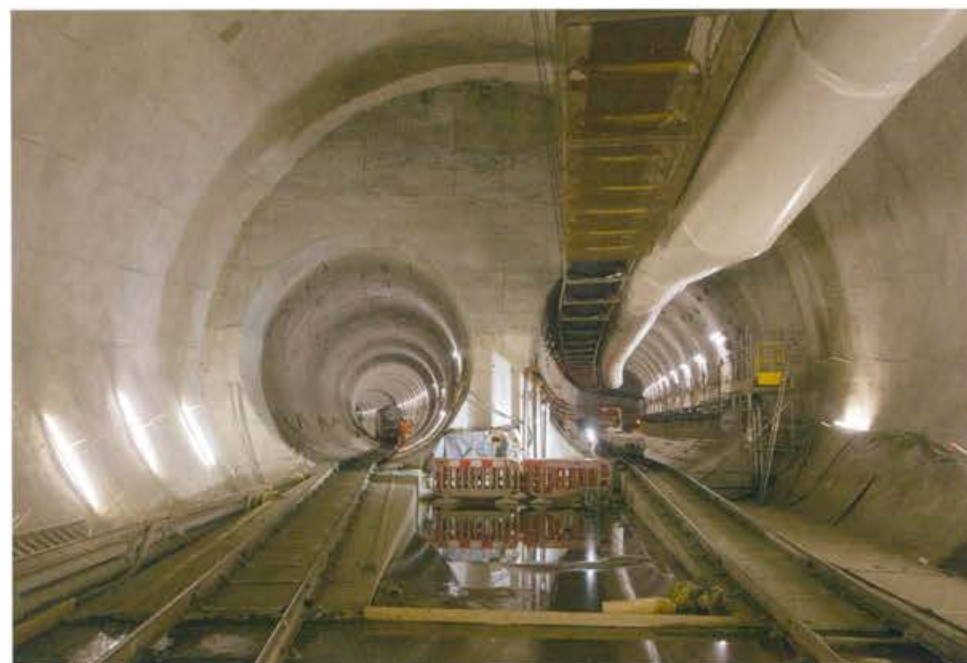
Doble tunel del Crossrail
