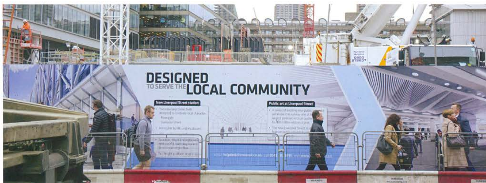
Obras del Crossrail-Morgate
