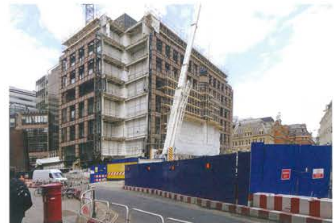
Crossrail Broadgate Entrance - construcción
