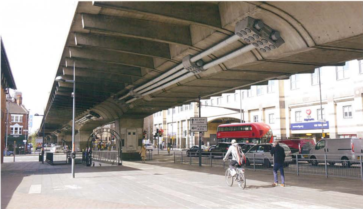
Hammersmith Flyover para los accesos a Heathrow, diseñado por G. Maunsell & Partners, y construido en 1961 por elementos prefabricados cosidos con cables postesados y posteriormente reforzados en 2011 con cables exteriores adicionales para suplementar a los interiores, atacados por filtraciones de agua.
