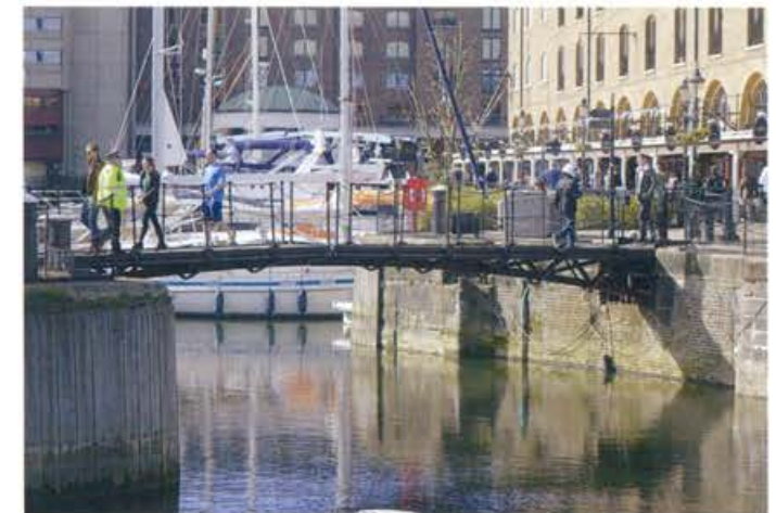
Puente retráctil de la dársena oriental
