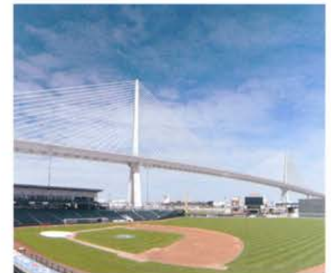
Harbor Bridge, EEUU
