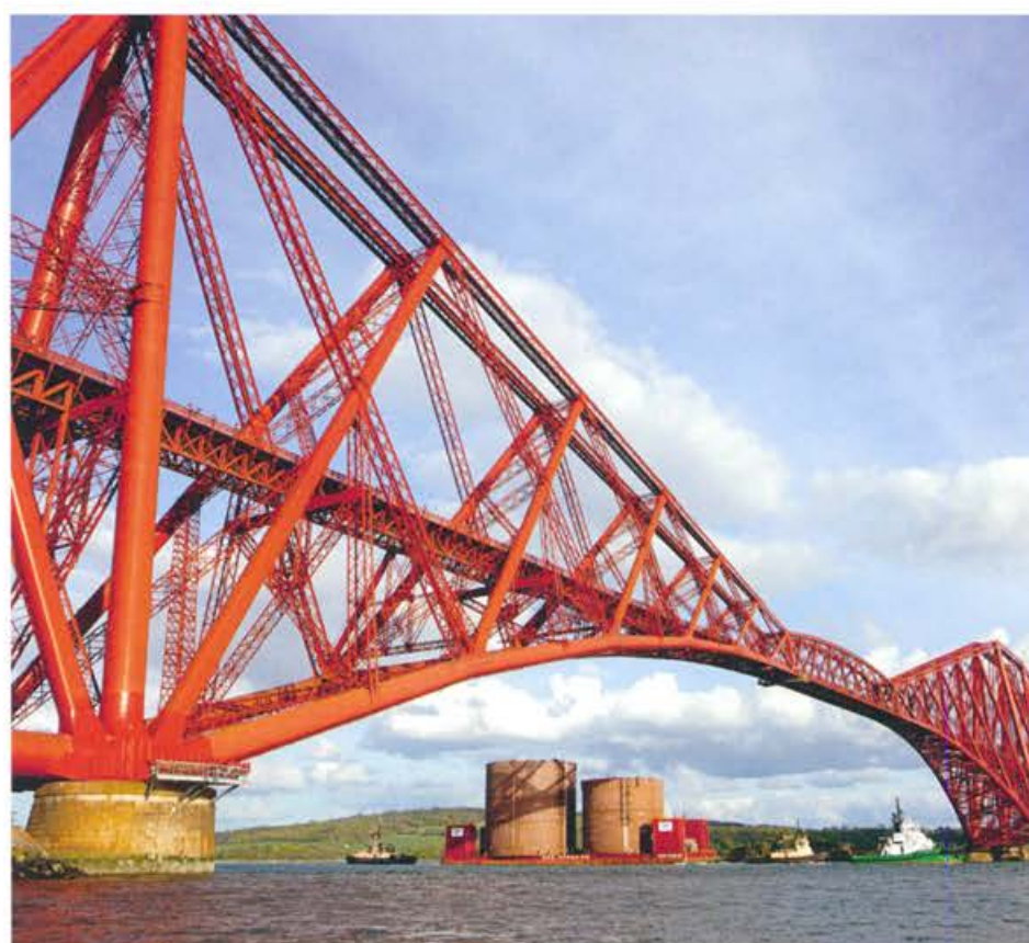
Nuevo Puente Queensferry Crossing, Escocia
