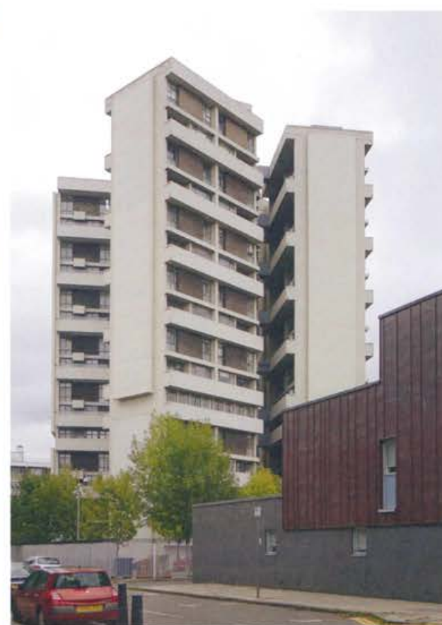
Keeling House en Bethnal Green, Denys Lasdun, 1955
