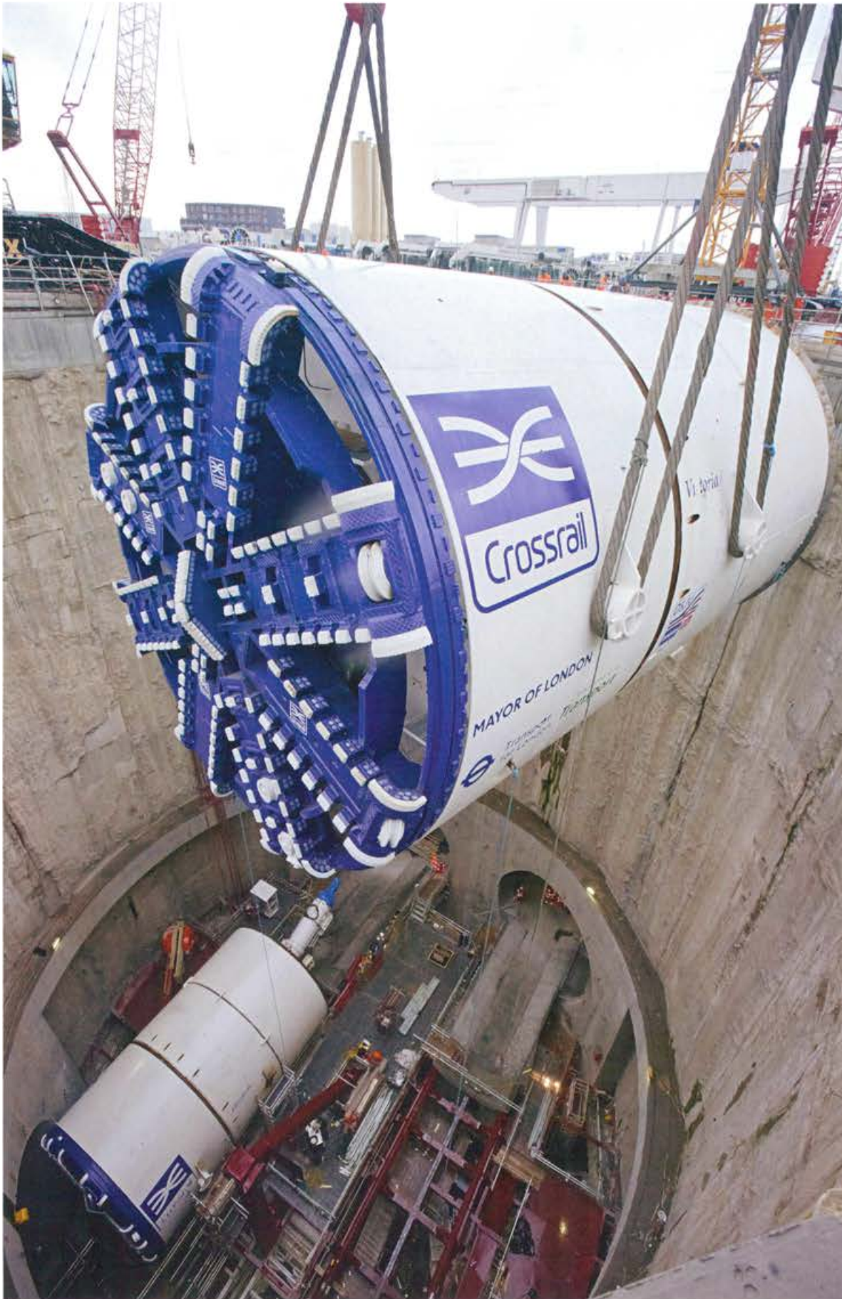
Tuneladora y túnel del Crossrail
