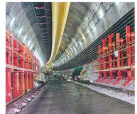
Seattle tunnel, EEUU
