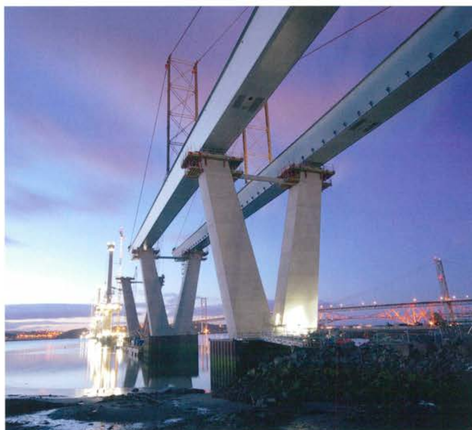
Nuevo Puente Queensferry Crossing, Escocia
