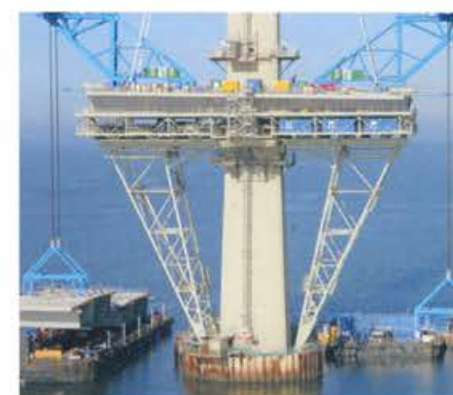
Autopista Windsor Essex Parkway, Ontario, Canadá. 2015
