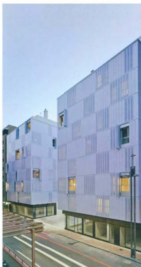
Edificio San Mateo, Murcia. 2016
