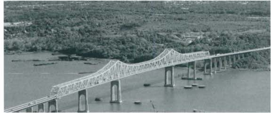
Outerbridge (John A. L. Waddell, 1928). Lowe, Jet, 1991.
