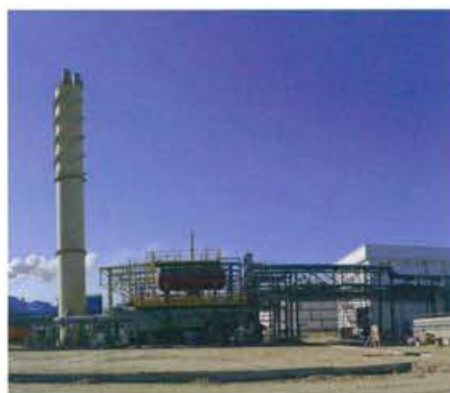
Vapor OCP Marruecos Intecsa
